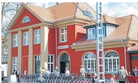
Der sanierte Bahnhof Chorin Foto: MLUV Archiv
